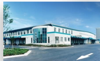
川越配送センター
