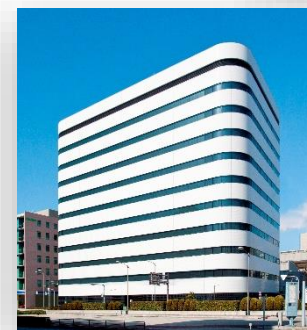
西心斎橋ビル
