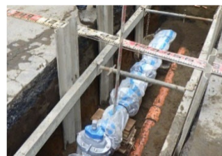
上水道入替工事
