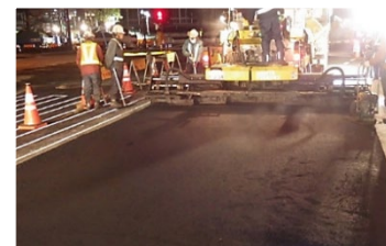
道路舗装工事
