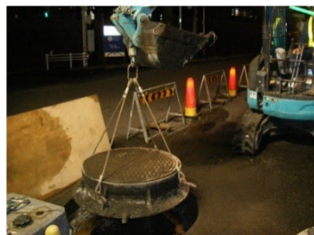
マンホール高さ調整工事
