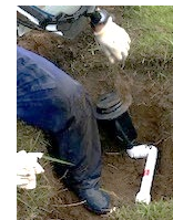
スプリンクラー 取替工事
