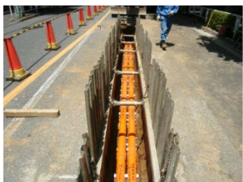
管路地中埋設工事
