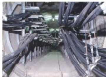
洞道地中建設工事
