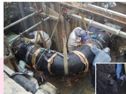
大口径導管溶接工事
