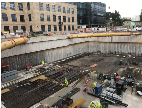
地下施設の耐圧スラブ
