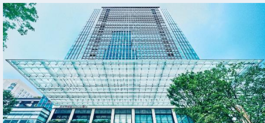
日本橋室町三井タワー
