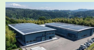
森本第3機械工場
