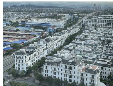
北部の戸建て住宅群
