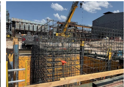
建設工事の様子 (2026.7)
