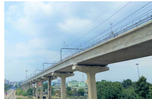
ベトナムホーチミン都市鉄道（地下鉄）
