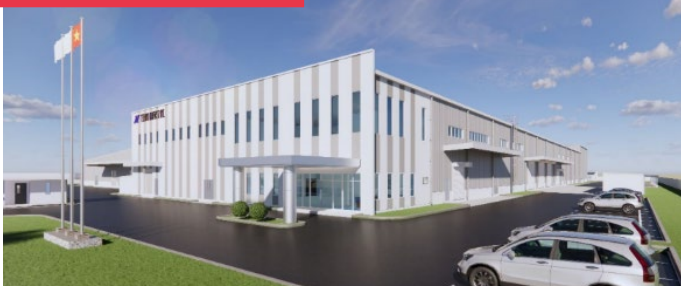
ベトナム 半導体事業生産棟
