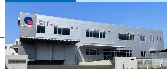
埼玉 分析機器事業生産棟
