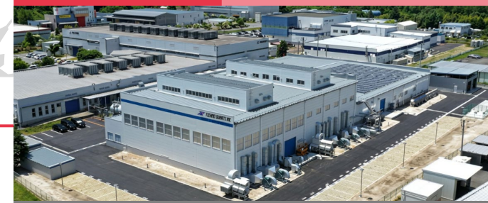
山形 半導体事業生産棟
