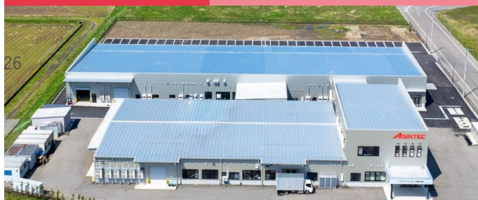
福島 半導体事業生産棟
