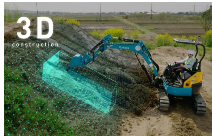
スマートコンストラクション （ICT建機）
