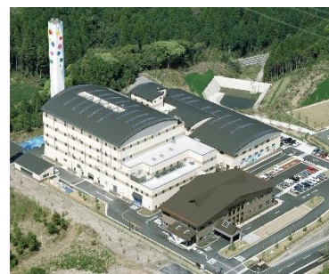
ごみ焼却・溶融プラント
