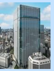
赤坂トラストタワー 延床面積: 209,436.75㎡
