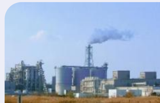
ボイラー（工場）
