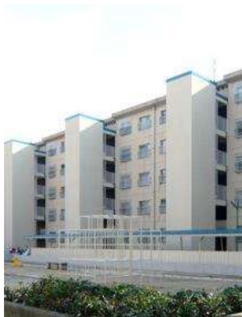
階段室型エレベーター
