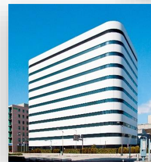
西心斎橋ビル
