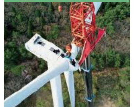
風力発電設備の解体
