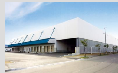
IIF 札幌 ロジスティクスセンター (札幌市白石区)
