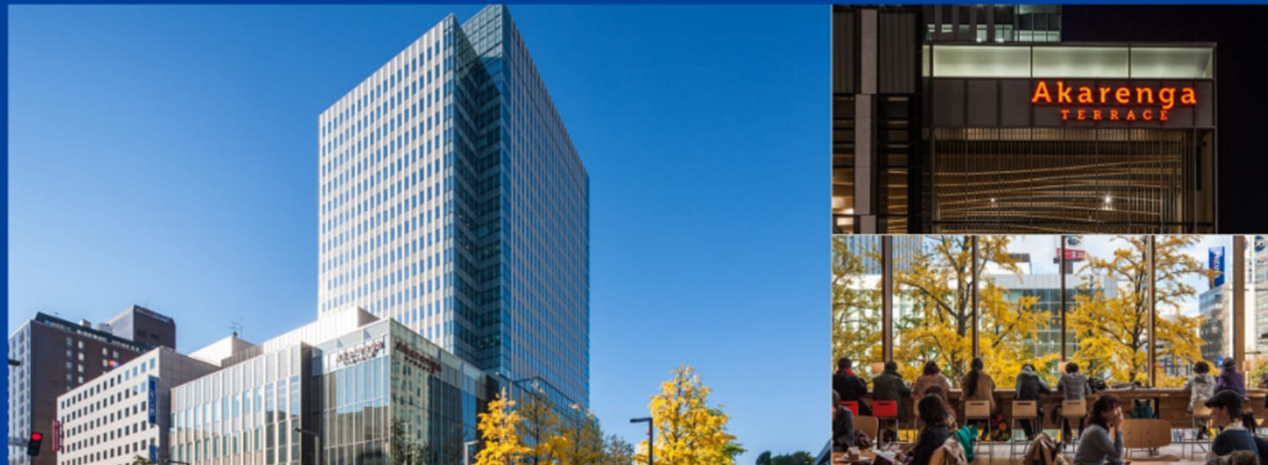
札幌三井JPビルディング | 北海道札幌市中央区北2条西4-1
