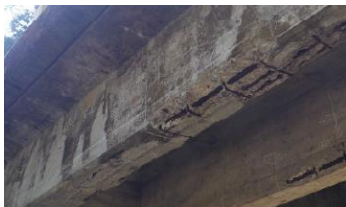
コンクリートのひび割れ
