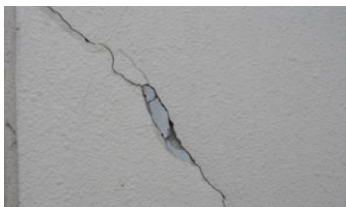
コンクリートのひび割れ
