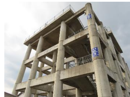
徳島県・海陽町の津波タワー
