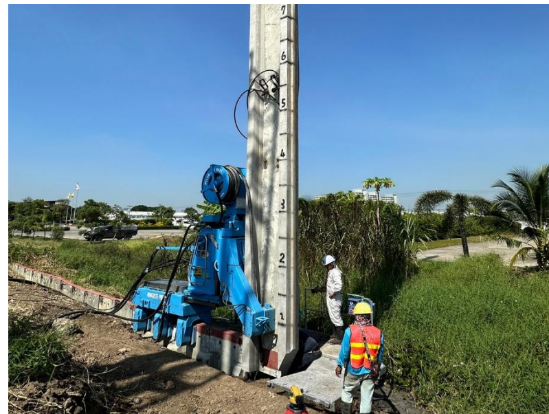
コンクリート矢板試験施工の様子
