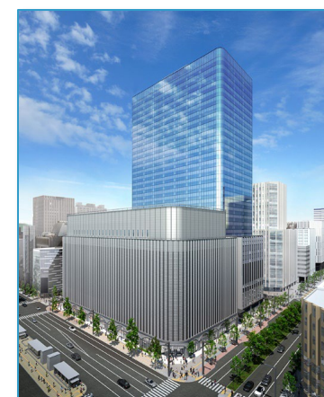
札幌駅南口北4西3地区 第一種市街地再開発事業 (札幌市)
