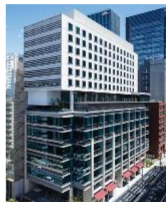
OVOL日本橋ビル
