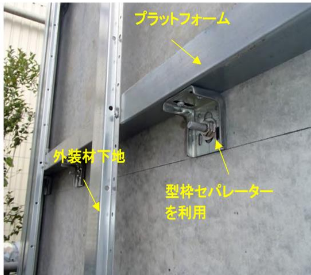
鋼製下地(プラットフォーム)詳細
