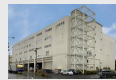
札幌白石配送センター
