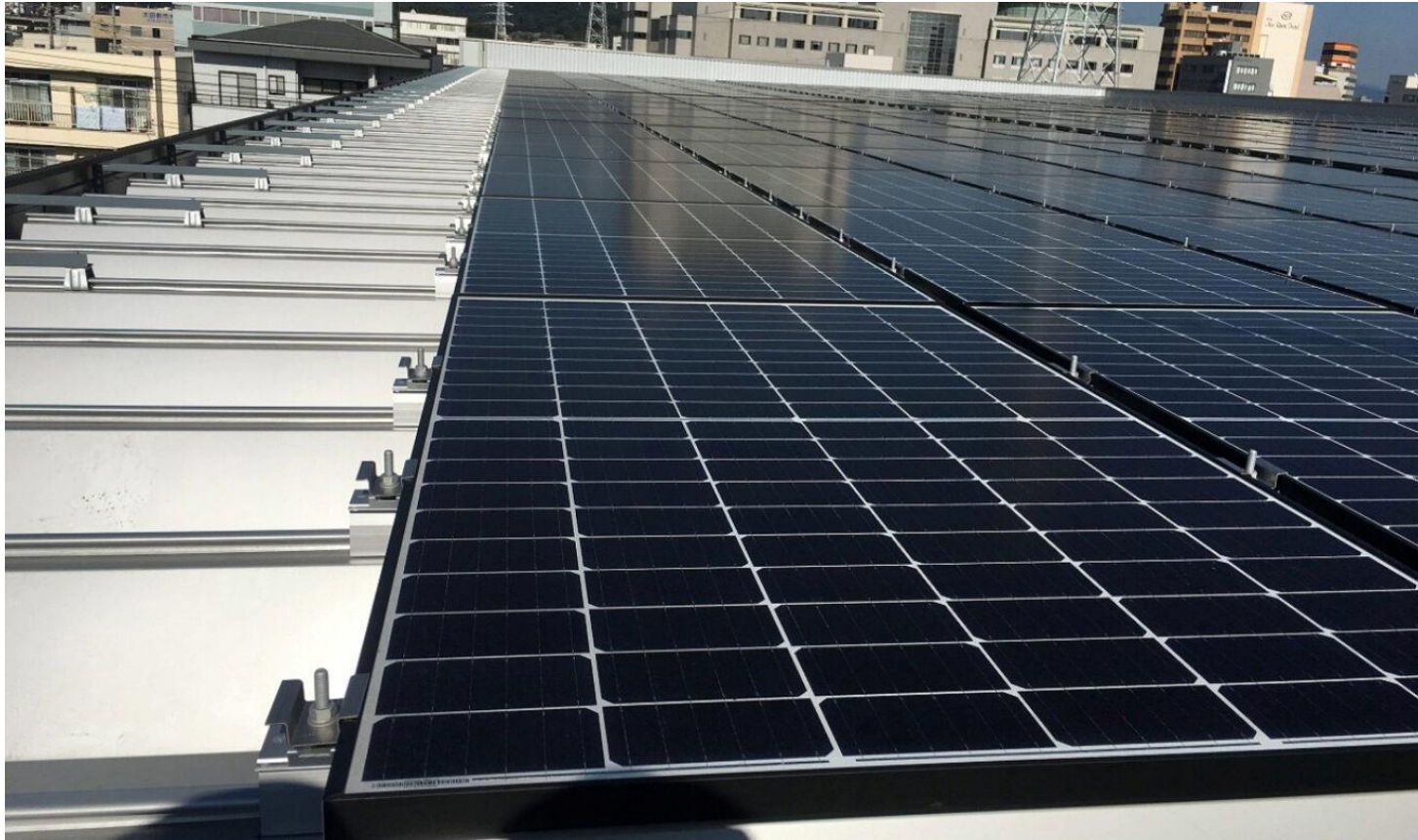
レンタルオフィスの屋根／太陽光発電設置工事
