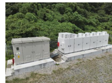
長崎第2太陽光発電所に導入した蓄電システム
