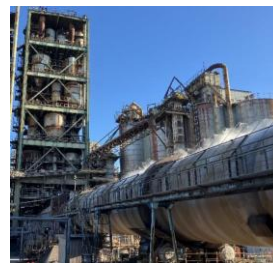
UBE三菱セメント(株)九州工場黒崎地区のセメント焼成用キルン・プレヒーター
