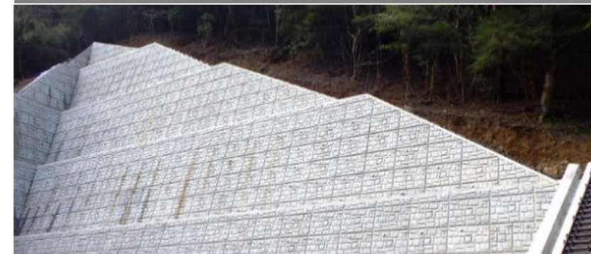
パンウォール工法 (地山補強土の独自技術)
