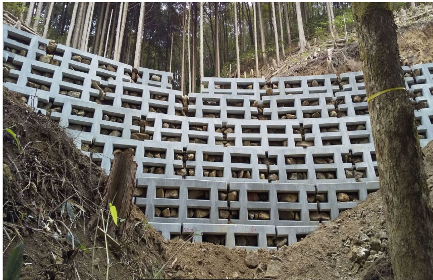
入江山林業専用道新設工事（島根県）
