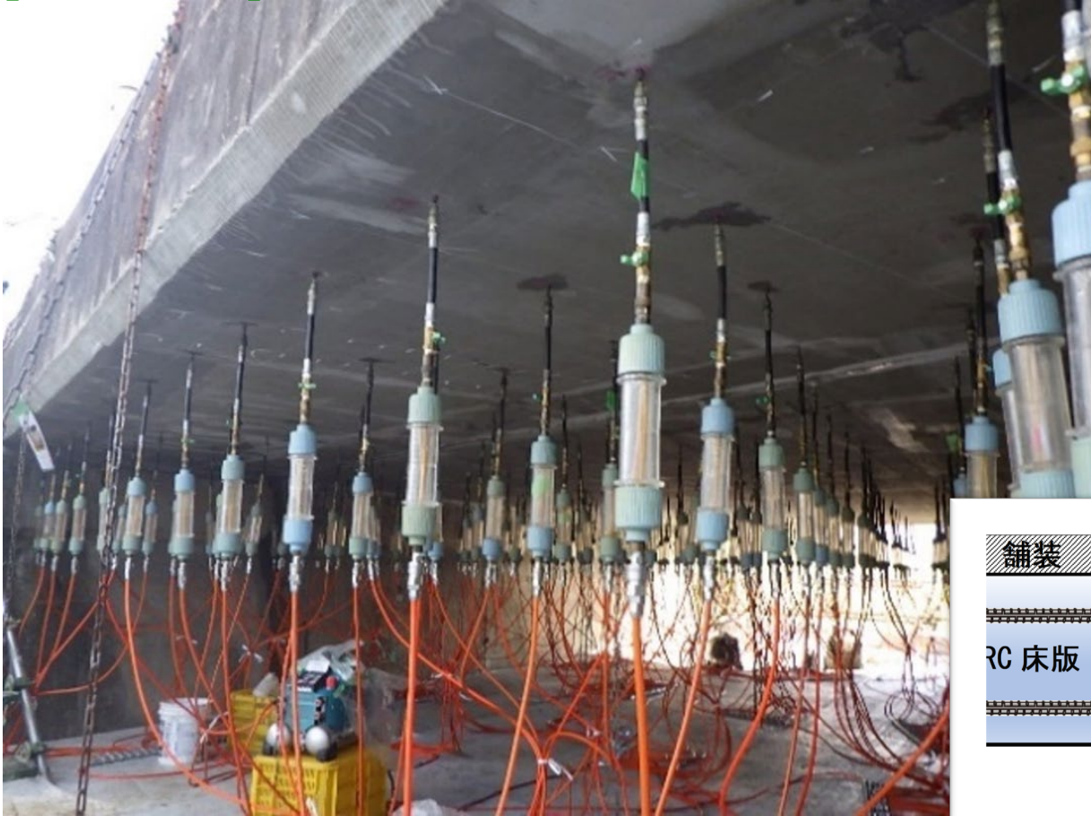
上大橋補修工事（和歌山県）
