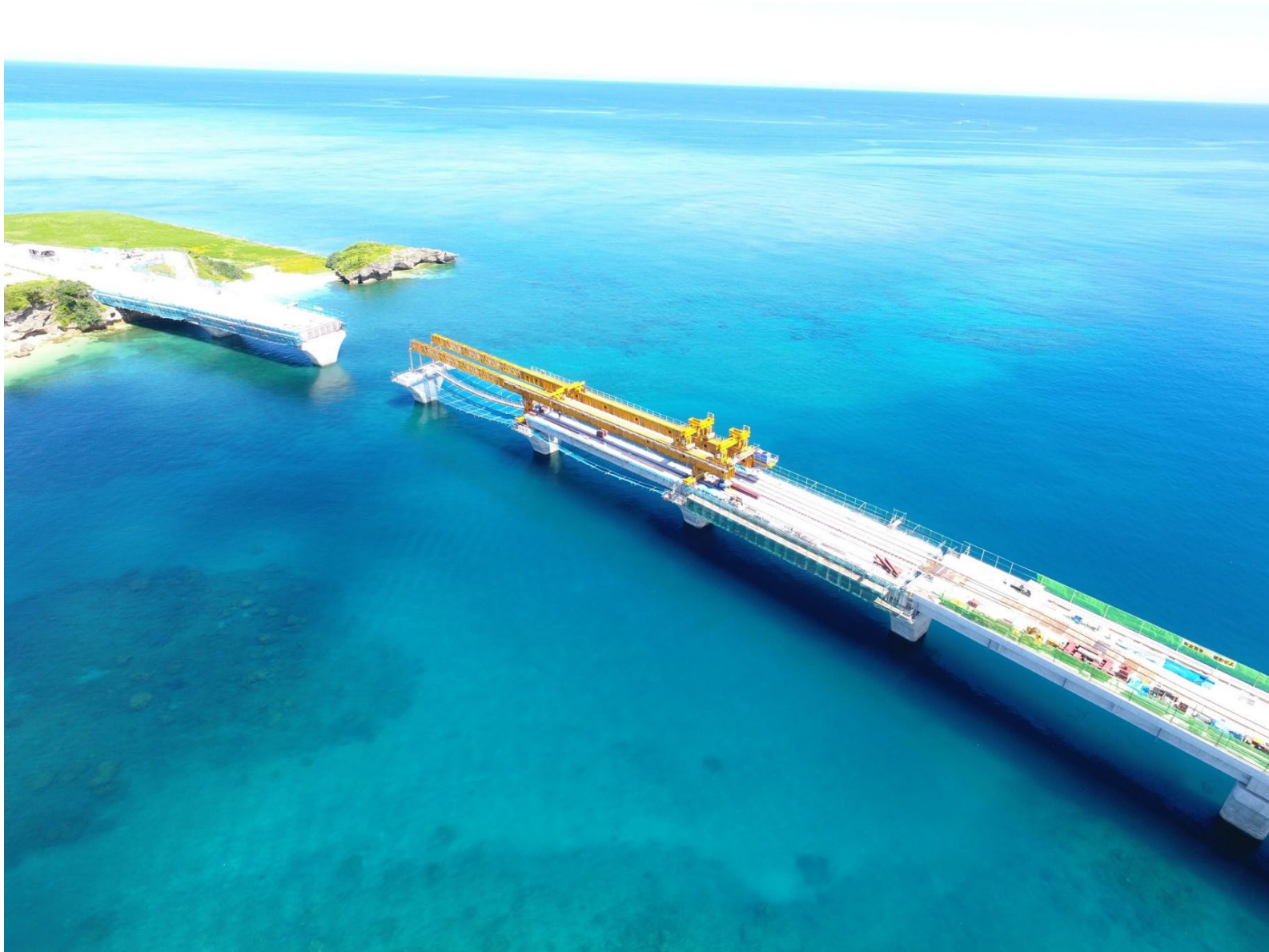
沖縄総合事務局 港川高架橋上部工外工事 沖縄県那覇市
