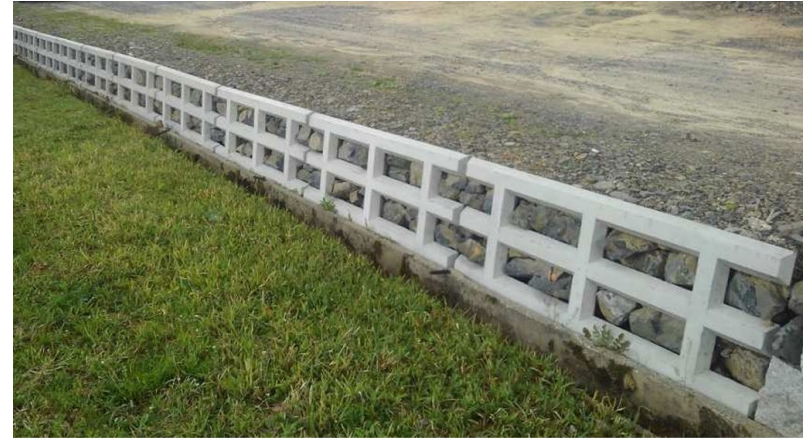
敷地内土留め工事（山口県）
