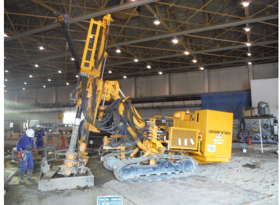
電力中央研究所実験棟 津波氾濫流水路実験施設新築工事（千葉県）
