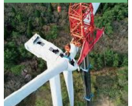
風力発電設備の解体
