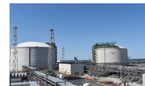
相馬LNG基地
