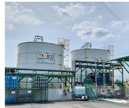
苛性ソーダタンク、塩酸タンク
