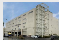
札幌白石配送センター
