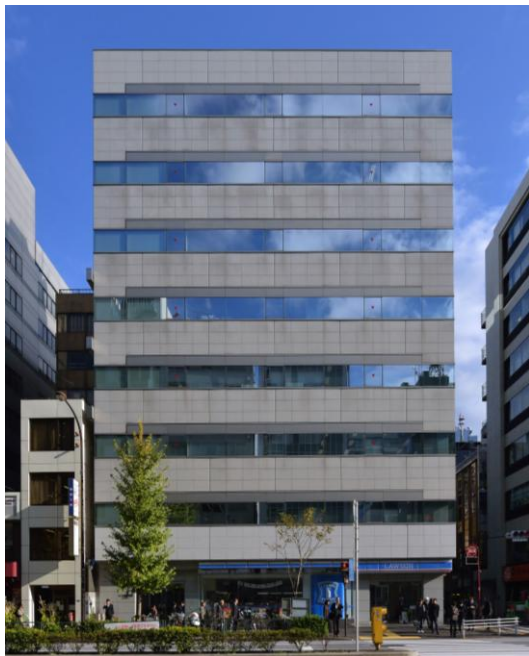
KDX新橋ビル （東京都港区）
