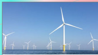
エネルギー変換グループ
