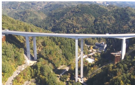
東海北陸自動車道 鷺見橋（橋脚高さ日本一）
