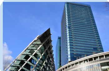
マンション・オフィスビルなど
