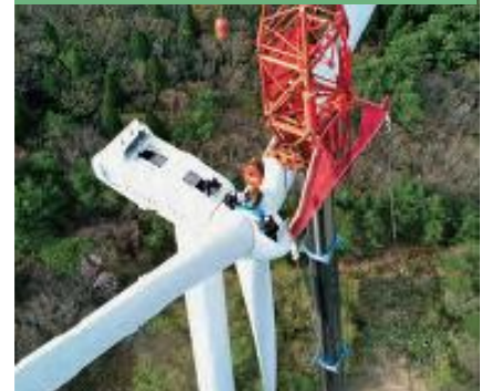
風力発電設備の解体
