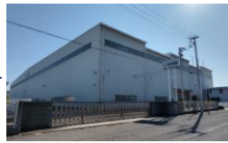
タダノ 丸亀工場 (新設中)
