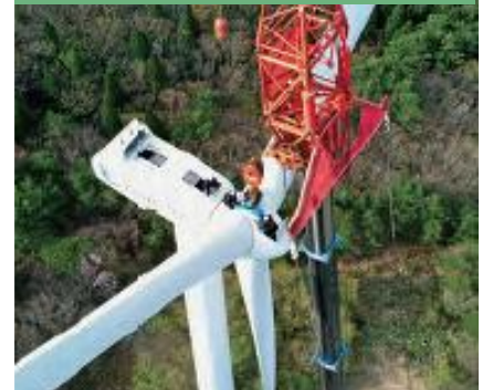
風力発電設備の解体
