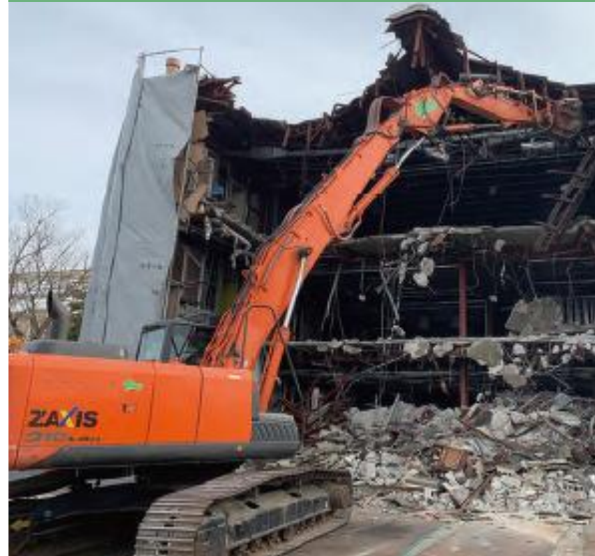
(株) アビズ旧本社事務所の解体
