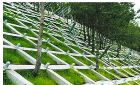
フリーフレーム工法
