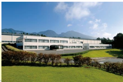
ASB本社／工場（長野県小諸市）
