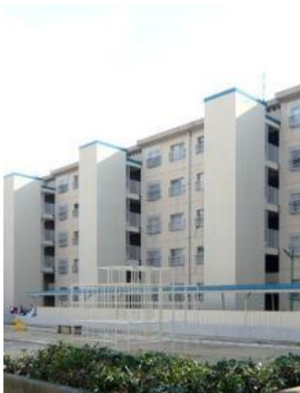
階段室型エレベーター
