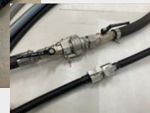
漏水防止やメンテナンス性に優れた配管、継手の検討
