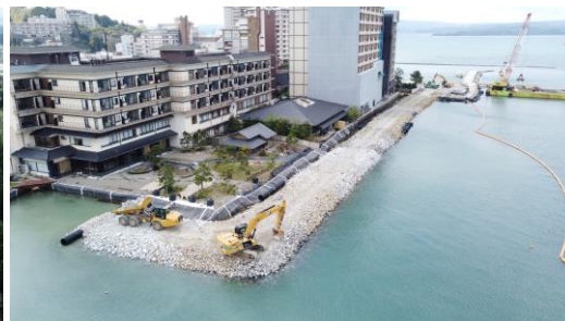
和倉港・和倉海岸護岸(東工区)(災害復旧)改良工事
