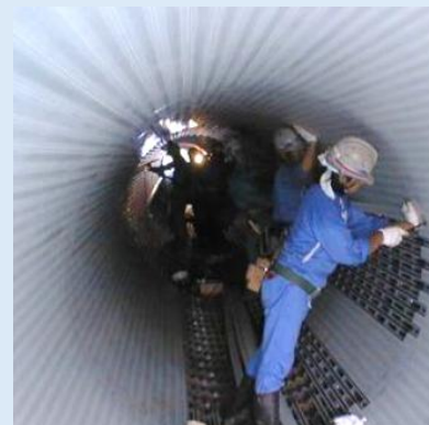
パルテム・フローリング工法
