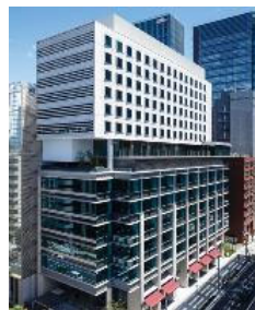
OVOL日本橋ビル
