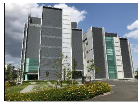
第2データセンター
