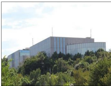
第1データセンター
