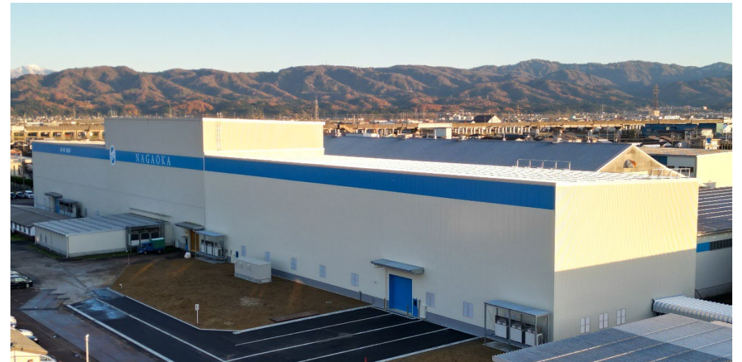
オーエム製作所 長岡工場（新潟） 2024年12月に工場の拡張工事が完了 長岡工場全体での生産能力が20%UP
