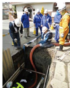
ガス導管の修繕作業 (仙台市)
