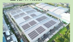
▲三和シャッター工業静岡工場
