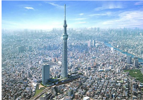
スカイツリー 冷暖房システム
