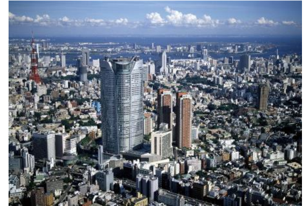
六本木ヒルズ 給水ポンプ等
