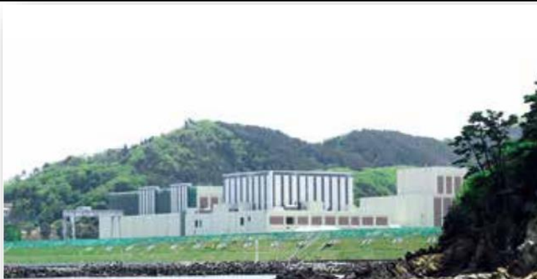
女川原子力発電所(2011年東日本大震災直後)
