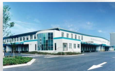
川越配送センター
