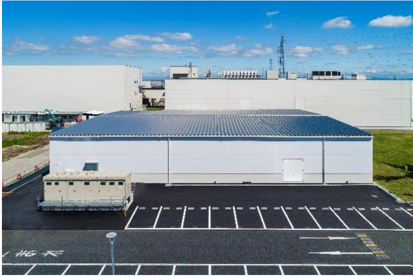
2号棟別館 2024年4月30日竣工
